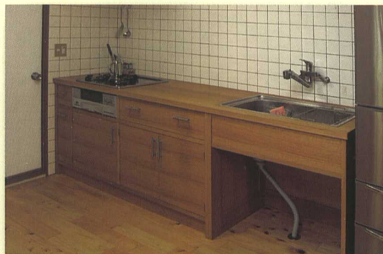
天板にも檜の無垢材を使用したキッチン
